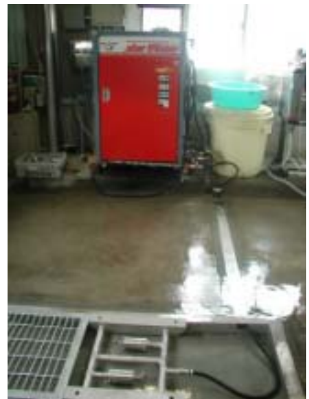
屋内設置例 200mm 幅 カプラ脱着でグレーチングに交換。
